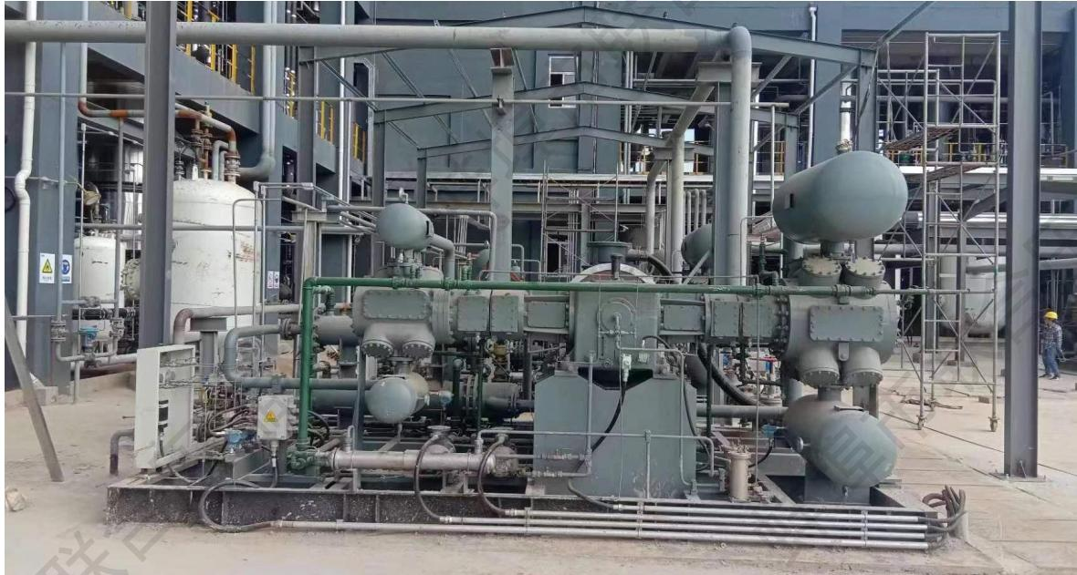
压缩机采用D型 (对称平衡式) 、开式水冷、无油润滑、往复活塞式、二列二级压缩，双作用，整套机组组成撬供应。压缩机具有耗能少、噪音低、振动小、可靠性高、无油润滑、操作简便等特点
