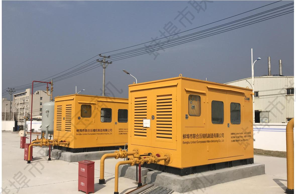
VWFD-7.2/ (0.15-0.2) -7压缩机采用角度式V型机型，两列，两级压缩。气缸、填料皆为无油结构，无油润滑。压缩机配有隔音方舱，舱体采用金属罩壳冷轧板材料（壳体四周墙壁为消音材料），舱内配有浓度报警器、防爆照明灯、防爆换气扇。方舱设有防爆玻璃，可直接透过玻璃观察设备仪表参数。
